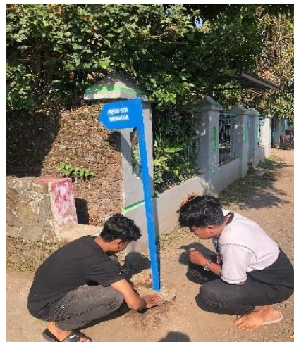
Gambar 15. Pemasangan Plang Jalan
