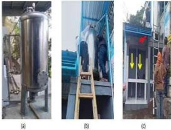
Gambar 3.1 (a) Bak tabung yang sudah jadi, (b) Bak tabung air di isi dengan material-material penyaring dan dinaikan ke atas, (c) Tanda panah merah adalah tempat peralatan ultraviolet (UV) sterilisasi ditaruh disitu, sementara tanda panah kuning tempat pipa untuk menampung air bersih setelah melalui penyaringan peralatan ultraviolet (UV) sterilisasi.
