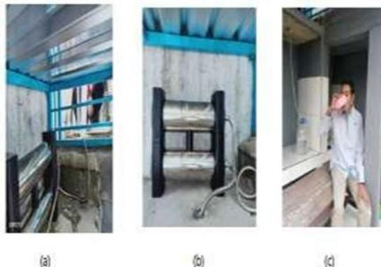
Gambar 3.2 (a) Peralatan ultraviolet (UV) sterilisasi disambungkan bak tabung air, (b) Pipa stainless steel pada Peralatan ultraviolet (UV) sterilisasi untuk mengalirkan air bersih, (c) Air bersih ditampung dalam gallon, dan siap untuk diminum. (Warga antusias untuk mencoba minum air tersebut).
