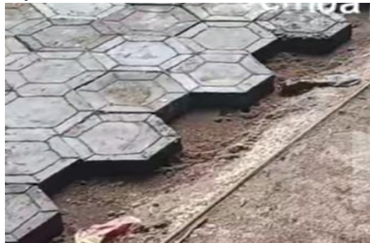
Gambar 10. Paving Sudah Jadi dan Dipasang
